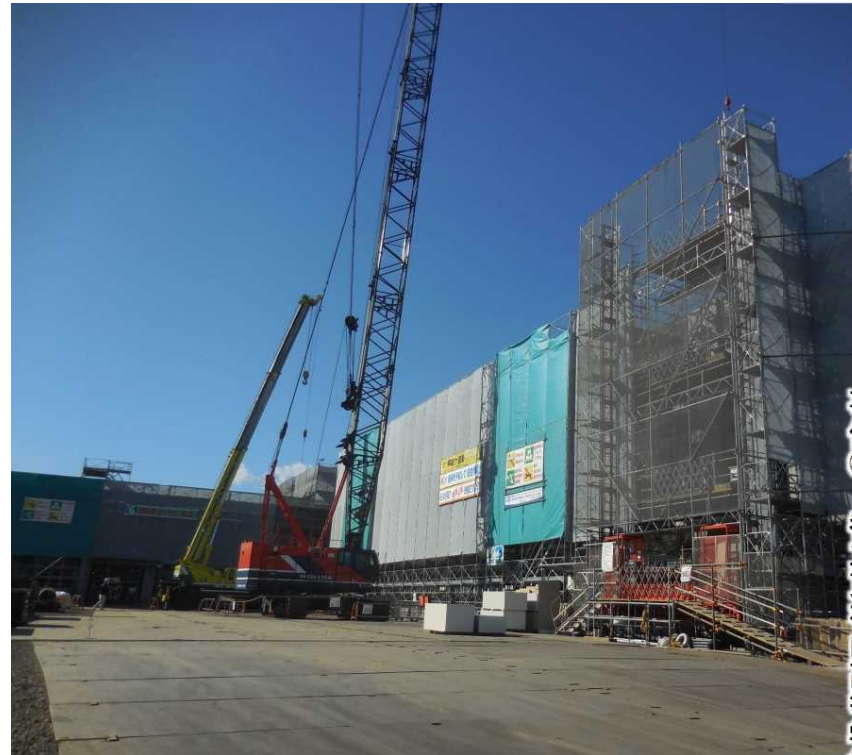
2019年11月末の施工状況
