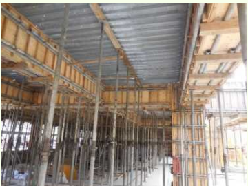
左：スライド式鋼製型枠の施工状況 右：梁鉄筋先組工法
