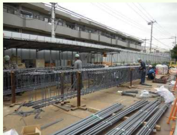
左：スライド式鋼製型枠の施工状況 右：梁鉄筋先組工法
