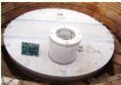
完成後の防火水槽。
