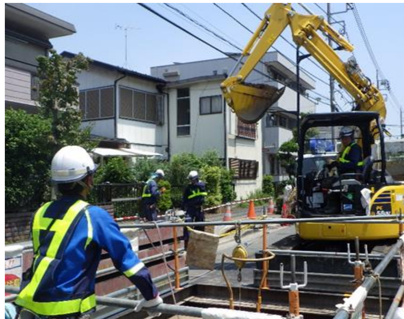
バックホウにて立坑を埋戻している様子。
