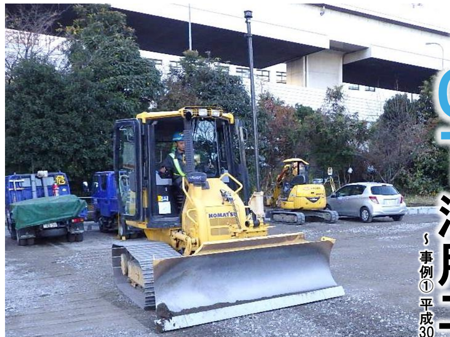
3D MCブルドーザーによる施工状況。
