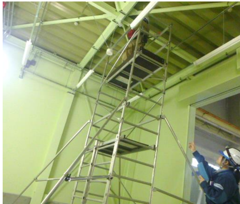
現場の施工管理を行う大西さん。
