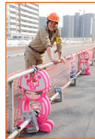
女性型安全柵の設置。
