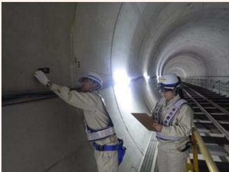
坑内の内空を確認する田島さんの様子。
