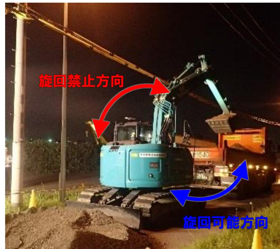
架空線側への旋回を規制している状況
