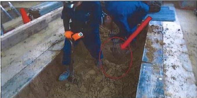
B-3 埋設物の手前にスコップなどを挿してバケット誘導の際の目印にする。
