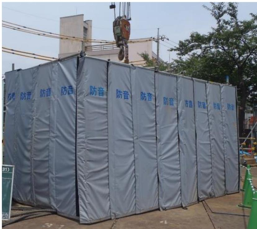
発電機の周囲に吸音パネルを設置
