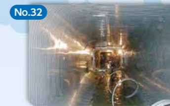
No.32 下水道管きよの更生工法 Sewer Rehabilitation Method
