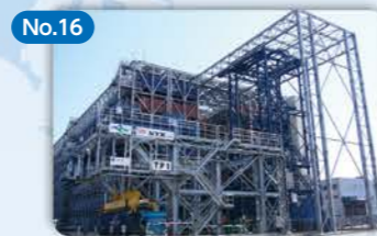
No.16 コンテナ立体格納庫の整備 Construction of a Multilevel Container Warehouse
