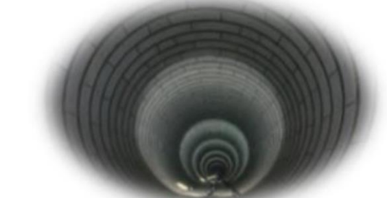
神田川・環状七号線地下調節池
