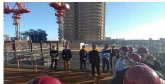
江東ポンプ所工事
