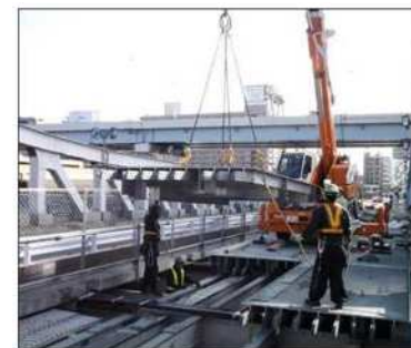
橋梁の長寿命化〈床版の取替〉 (施設の持続的保全)
