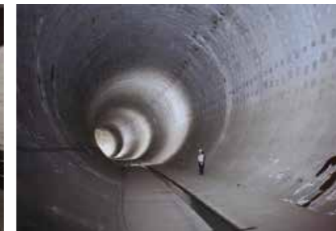
地下トンネル式
