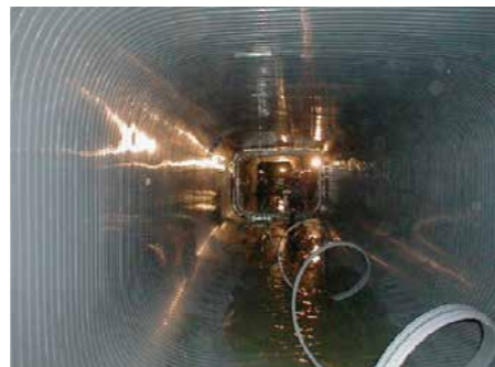
再構築中の下水道管
