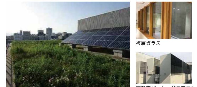
太陽光発電設備・屋上緑化
