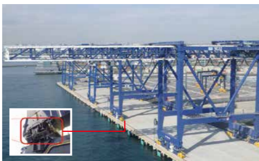
大規模地震に対応した免震装置付クレーンの採用
