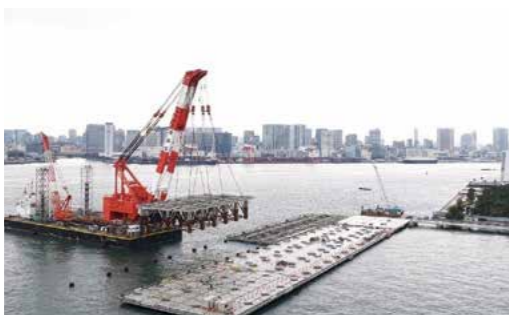
耐震強化岸壁にジャケット工法を採用
