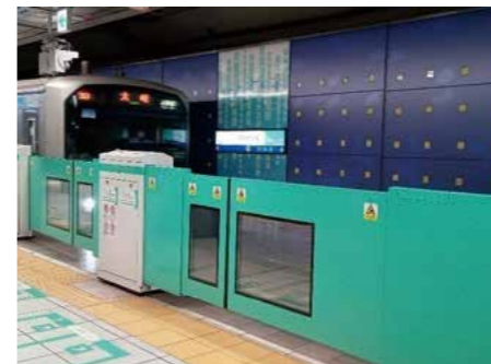
ホームドアの設置状況 48%
