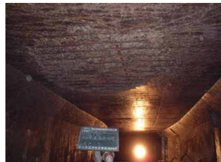
再構築前の下水道管
