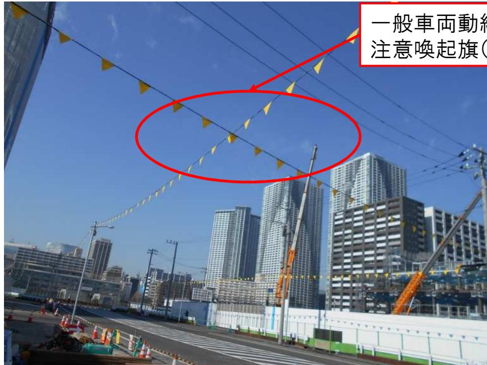
一般車両動線の横断架空線や工事予定箇所付近にある架空線に注意喚起旗(黄旗)を設置した。
