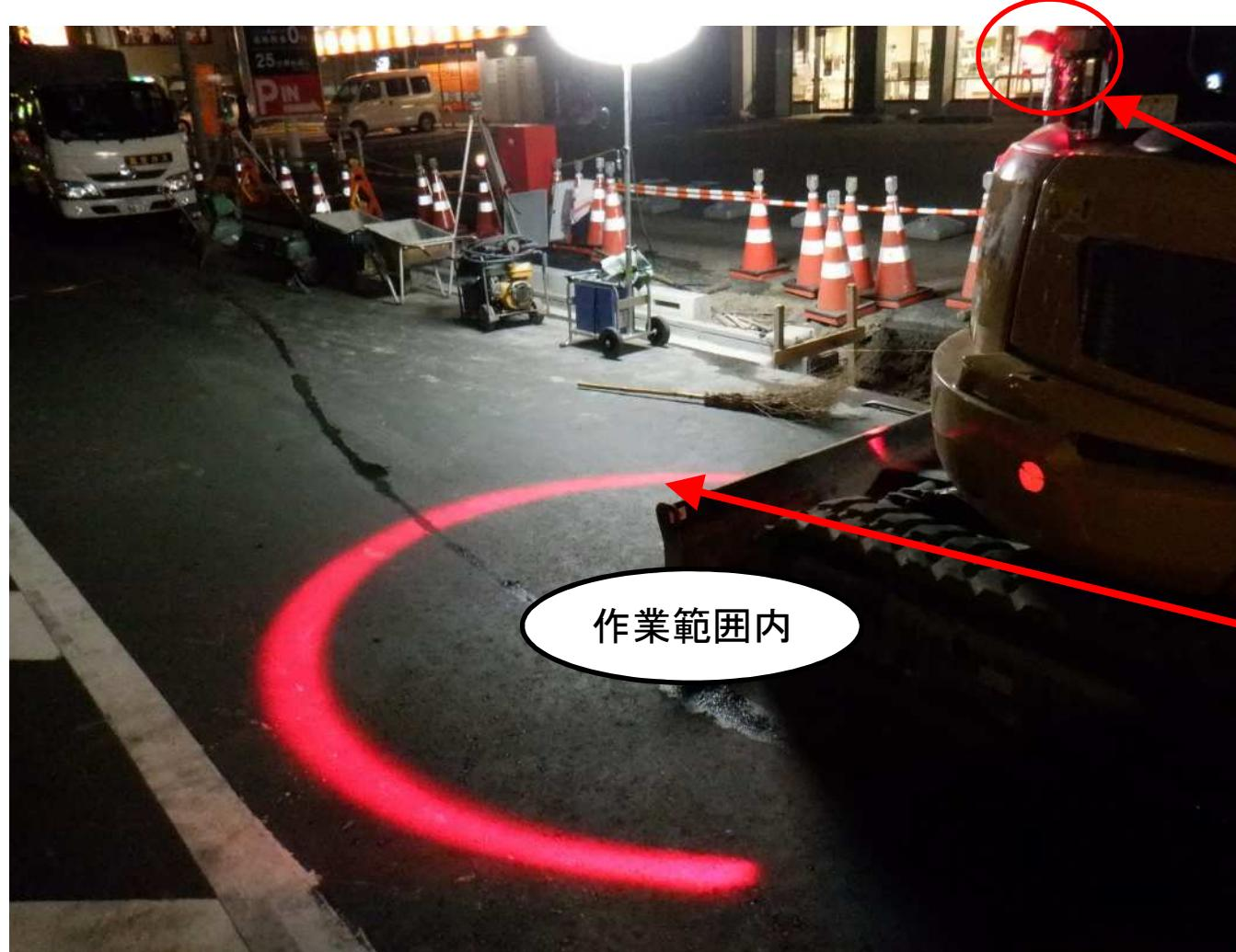
【重機に取り付けたビームライトで、重機作業範囲を照らしている状況】
