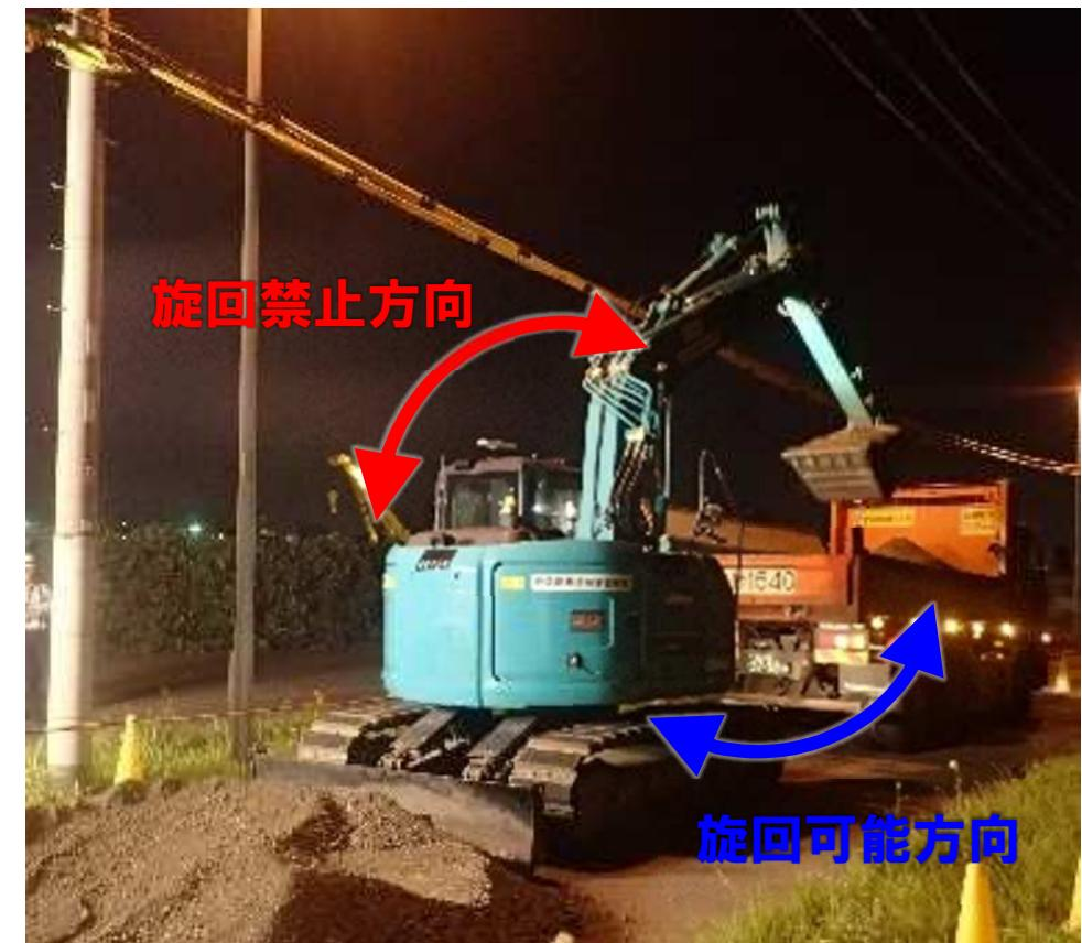
架空線側への旋回を規制している状況
