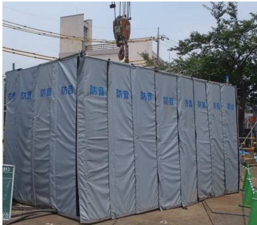
発電機の周囲に吸音パネルを設置
