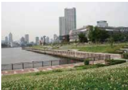
<海上公園の緩傾斜防潮堤>
