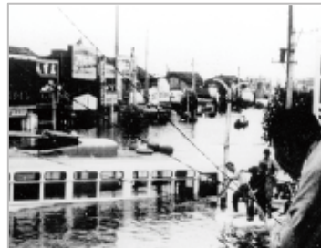
<昭和24年のキティ台風による浸水被害の状況>
