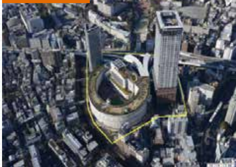
<整備後：地区全体>
