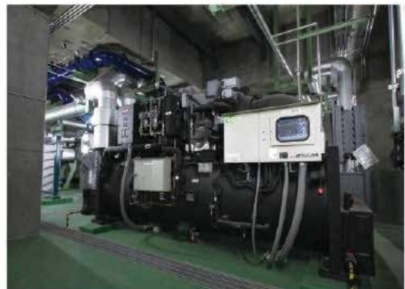
<熱供給システムのヒートポンプ>
