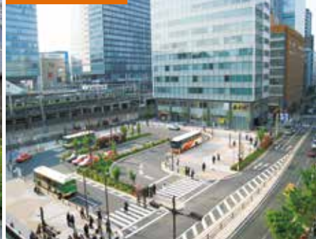
<整備後：駅前広場>
