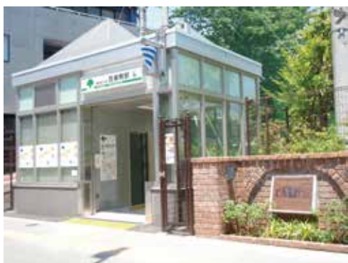
<エレベーター>
