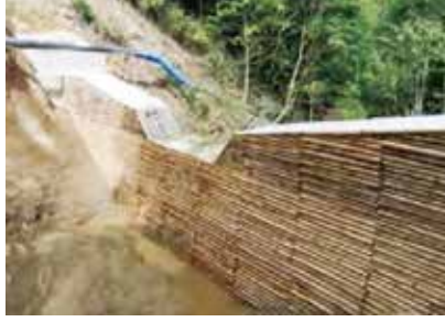
<コンクリート型枠への活用>
