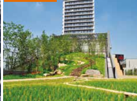
<整備後：屋上公園>
