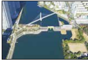
<水門・排水機場>
