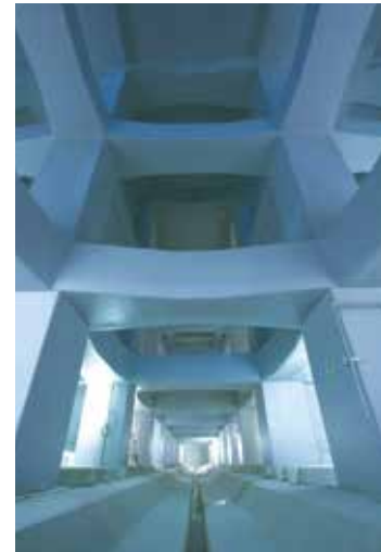
＜貯留施設 (芝浦水再生センター雨天時貯留池)＞
