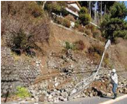
<（自然災害）土砂崩れ >
