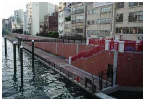
<スロープ・階段設置状況>
