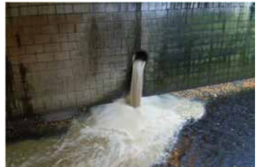
＜雨天時の合流式下水道の吐口からの放流＞
