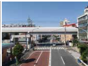
＜連続立体交差事業＞
