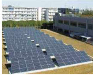
<太陽光発電パネルの設置（配水池上部）>
