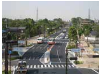
＜多摩南北道路整備＞
