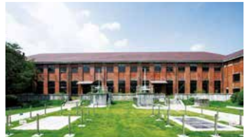
＜旧三河島污水処分場唧筒（ポンプ）場施設＞
